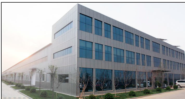
Nossa mais recente inaugurada (Maio de 2014) instalação de fabricação de última geração.
